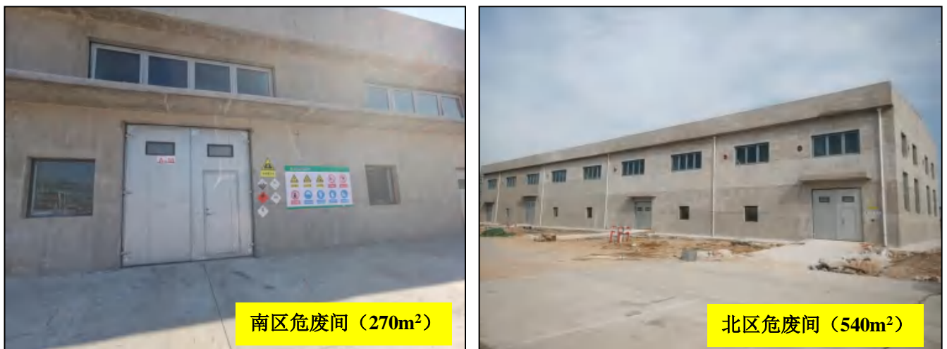
图 4-4 危废暂存间现状
