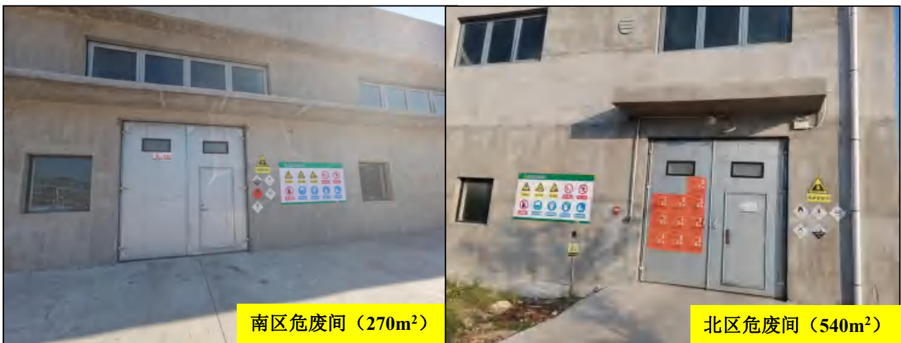
图4-4 危废暂存间现状
